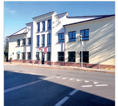
Budynek technikum został w zeszłym roku wyremontowany. Fot. M. Bieleśz
