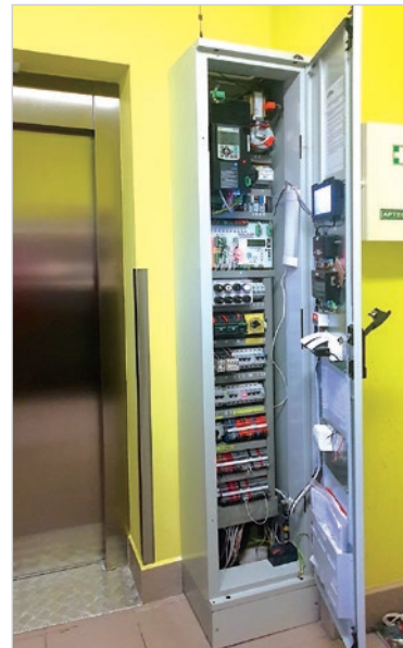
Dzięki wymianie windy budynek MDSS zyskał nowe pomieszczenie gospodarcze, bo zlikwidowano starą maszynownię dźwigową. Fot. Miasto Ustrów
