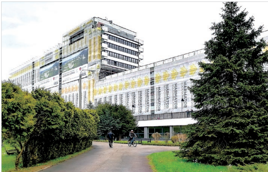
Na budynku sanatorium trwają już prace budowlane obejmujące termomodernizację, remont balkonów i tarasu widokowego. Fot. M. Bieleś
