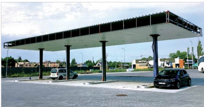
Po drugiej stronie drogi stoi już szkielet stacji benzynowej. Fot. M. Bieleś
