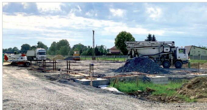
Prace na terenie mającej powstać galerii już trwają. Fot. M. Bieleś
