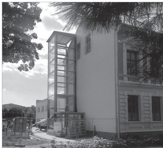
Trwa montaż windy przy zabytkowym budynku biblioteki, w którym znajduje się także siedziba naszej redakcji. Winda umożliwi dostęp do pomieszczeń wewnątrz osobom niepełnosprawnym.
