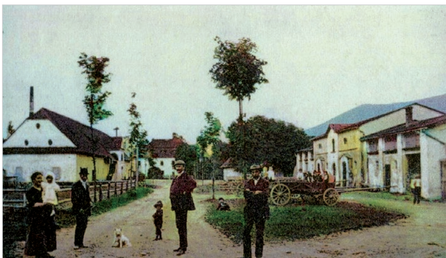
Folwark w Hermanicach pod zarządem Komory Cieszyńskiej – karta pocztowa z 1910 r. Z prawej strony stajnia (z fragmentem ozdobnego detalu w postaci głowy konia), za nią wozownia, w tle czworak, na lewo od niego dwór. Z lewej obora, a za nią komin gorzelni.
