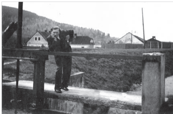
Jerzy Gromnica pozujący na terenie dawnej Młotowni „Teresy”, przy kanale okrężnym stawu z jazem zasuwowym dwuprzęsłowym i korbowymi mechanizmami napędu zasuw. W tle od prawej: hala dawnej papierni i młotowni, budynek administracyjno-mieszkalny oraz dom dla robotników, okalające centralny plac założenia przemysłowego. Koniec lat 40. XX w. Fot. ze zbiorów Anny i Ewy Depty
