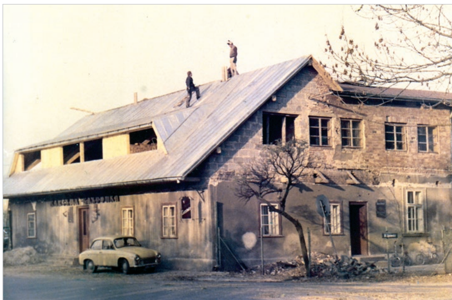
Remont „Gazdówki” na początku lat 80.
