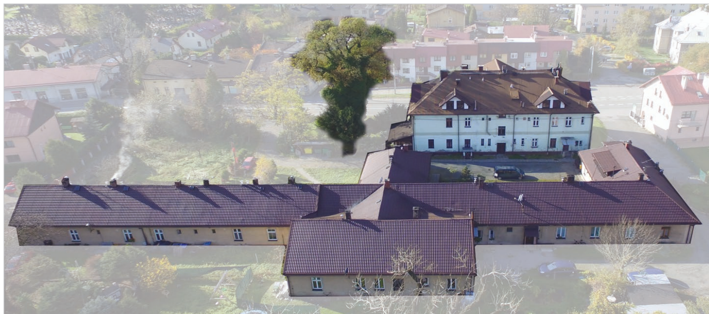
Współczesny widok na oba obiekty osiedla Donatówka wykonany z drona przez Bronisława Miecha. Na pierwszym planie zabytkowe mury dawnej miedziarni Kohlhauptów.
