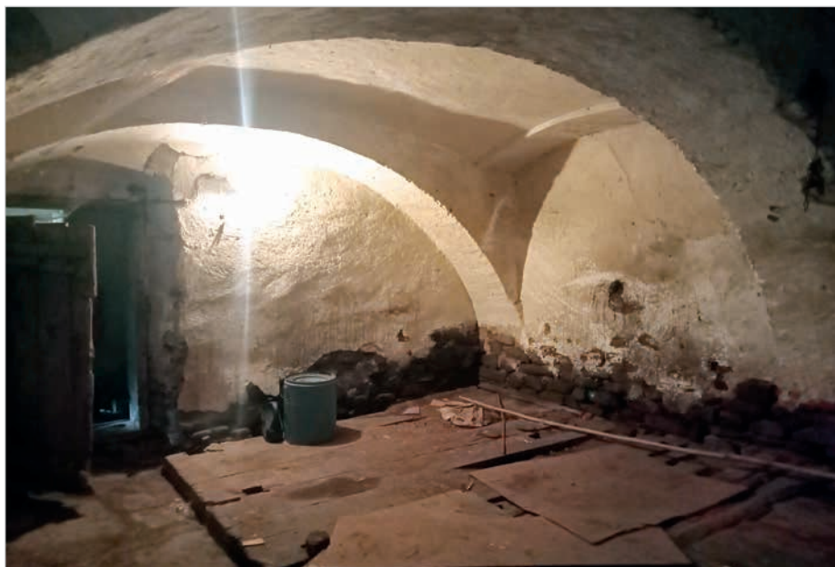
Pięknie sklepione piwnice z 1770 r.
