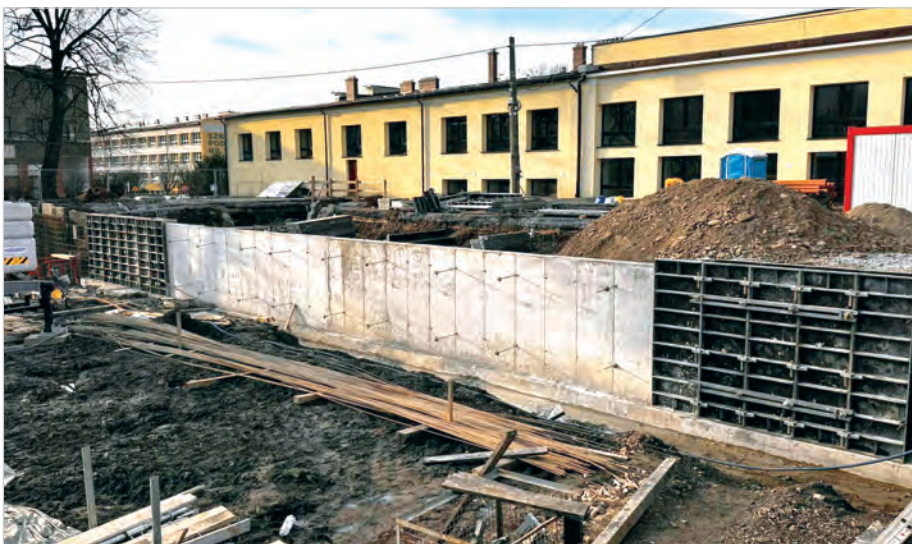
Na terenie budowy powstały żelbetowe umocnienia przy brzegach zbiornika.
