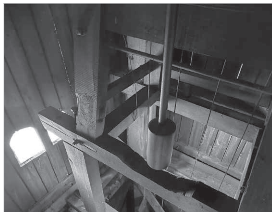
Drewniane rusztowanie w środku wieżyczki w dół którego opuszczają się imponujące odważniki. Z lewej małe okienka wieżowe.
