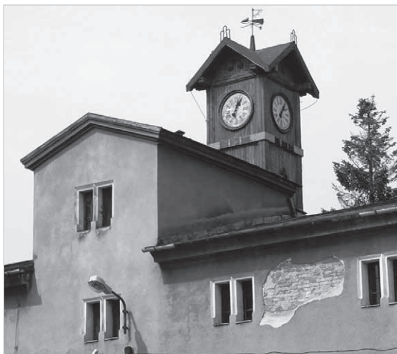
Magazyn główny z wieżyczką, widok od południa.
