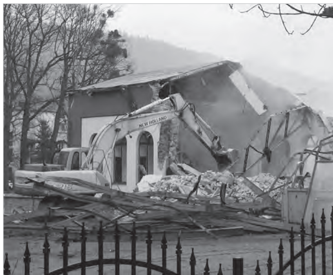
Prace wyburzeniowe Salonu Kuracyjnego, 10.12.2024 r.
