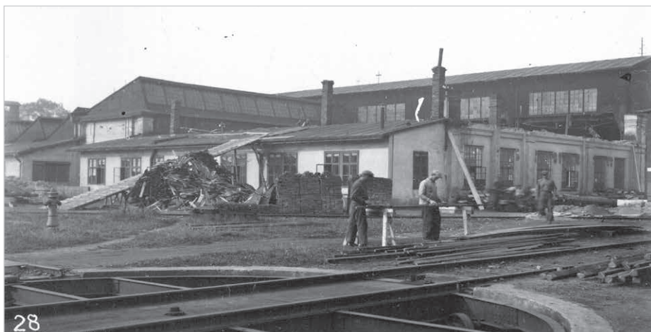
Imponująca obrotnica w północno-wschodniej części zakładu, sfotografowana przez Józefa Skorę w 1937 r. czyli w czasach, gdy Kuźnia działała jako Fabryka Srub i Wyróbów Kutych Brevillier-Urban. W tle narzędziownia i warsztat mechaniczny, zaaranżowane w zabudowaniach po Zakładzie Budowy Maszyn.
