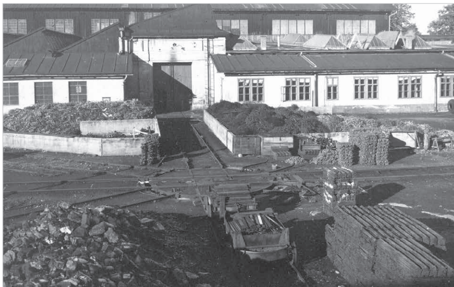
Kolejna okazała obrotnica, zlokalizowana od wschodniej strony Kuźni. To do niej dochodziły tory przebiegające bezpośrednio przez wnętrze Zakładu Budowy Maszyn, aby ułatwić transport kolosalnych wyrobów, z których słynął Ustron. W tle dawny warsztat mechaniczny. Fot. z 1937 r.
