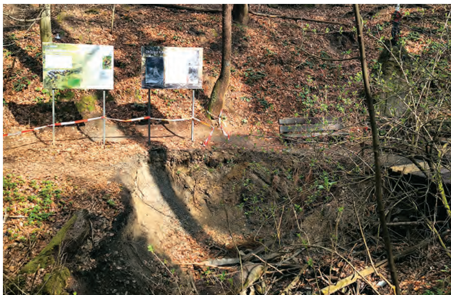
Zniszczona ścieżka prowadząca do Źródła Karola.
