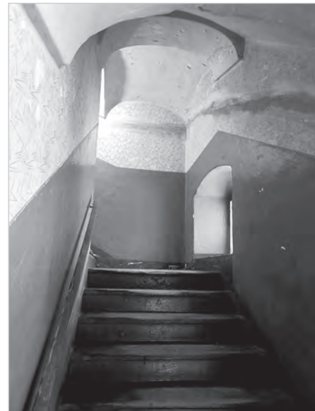
Fragment klatki schodowej.
