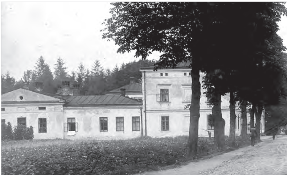
Fragment zabudowań Markusówki połączonej z dawną kamienicą Eisnerów, zakupioną po pożarze przez hutę.
