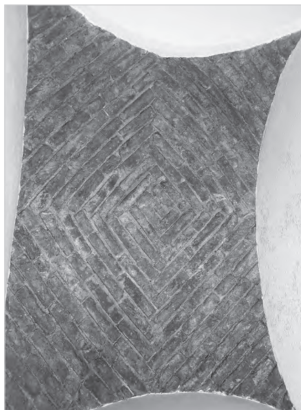
Sklepienia w mieszkaniu, ukazujące oryginalny układ cegieł.
