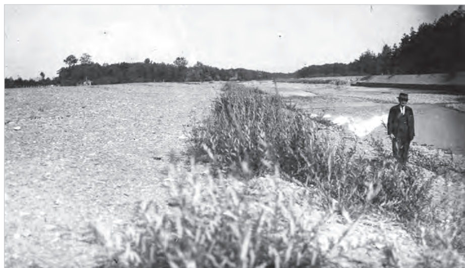
Regulacja rzeki Wisły w Nierodzimiu na wysokości kościółka św. Anny, na km 41+80, widok w stronę Harbutowic.
