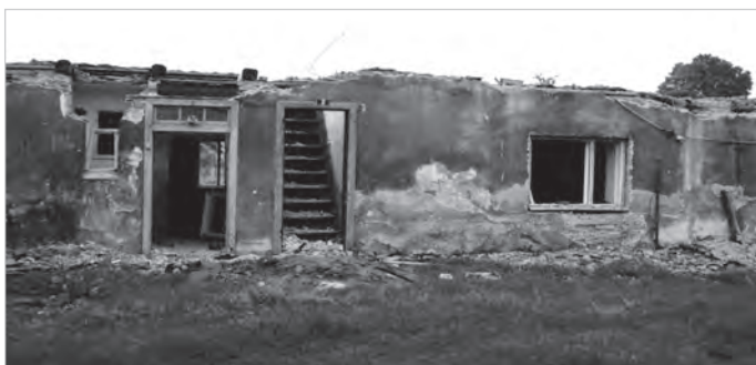
Rozbiórka domu usytuowanego w głębi podwórza na ujęciu Wojśława Suchty, wrzesień 1994 r. Jej powodem był zły stan techniczny obiektu, liczącego wówczas 118 lat.
