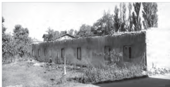
Rozbiórka domu znajdującego się przy głównej ulicy na ujęciu Wojśława Suchty.
