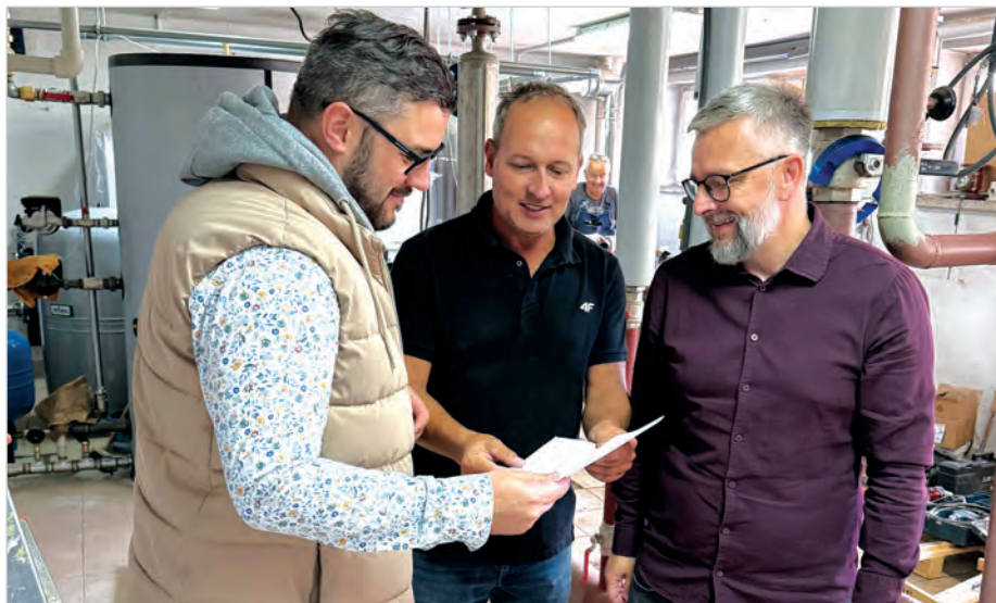
Powstaje nowa kotłownia w Szkole Podstawowej nr 2.
