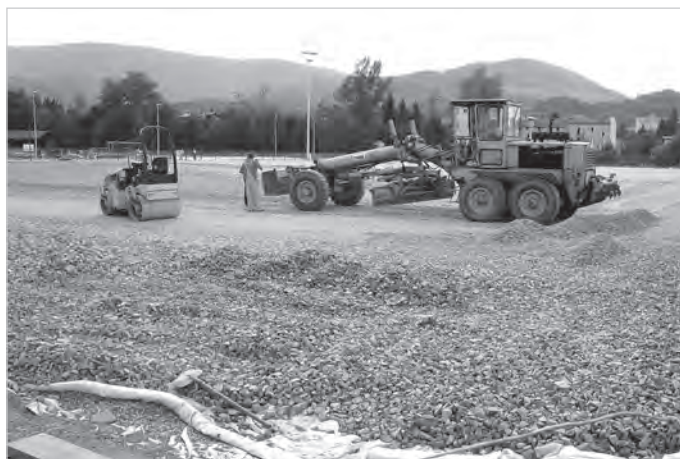
Przebudowa stadionu Kuźni.
