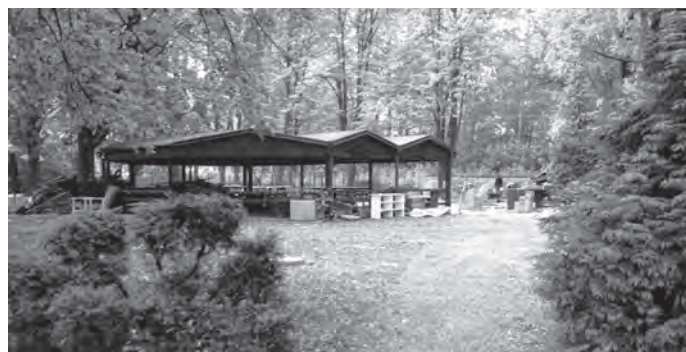
Rozpoczęła się modernizacja lokalu nad Wisłą, znanego jako „Utropek”. Fot. W. Suchta
