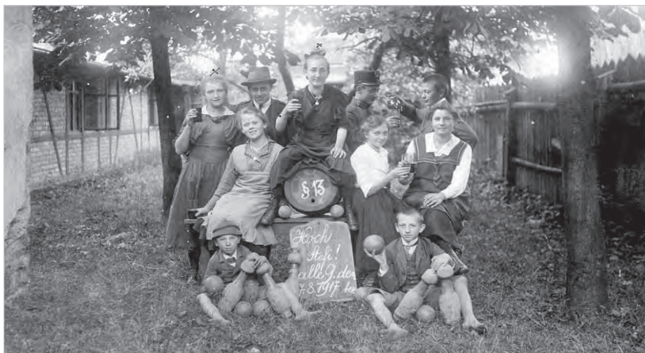
Ustronńska kręgielnia była również miejscem świętowania w gronie przyjaciół. Z prawej róg nadszarpniętej zębem czasu promenady oraz spory fragment strzelnicy. W tle, w oddali, młyn, istniejący ongiś przy ul. Słonecznej. Siedzący na trawie chłopcy prezentują oryginalne, drewniane kręgle oraz kule, co czyni to zdjęcie niezwykle wartościowym dokumentem.
