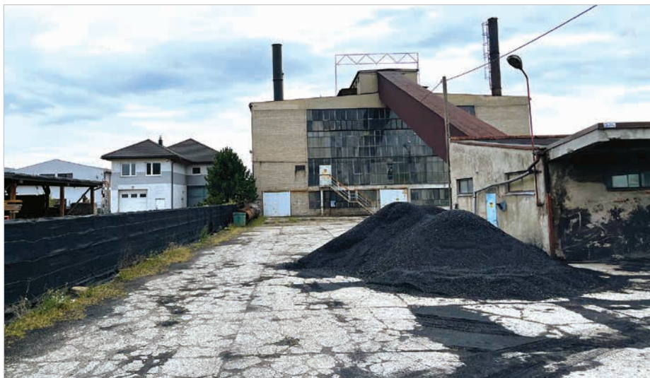
W związku z likwidacją kotłowni zostaną zdemontowane ciepłociągi naziemne w okolicach ul. Krzywej i Polnej. Fot. Przedsiębiorstwo Komunalne
