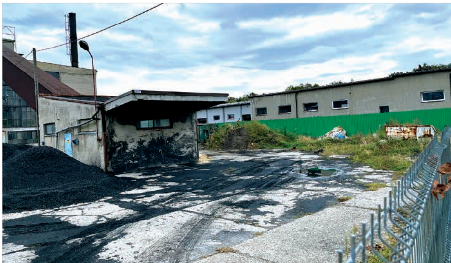
Obiekt dawnej kotłowni ma zostać rozebrany.
