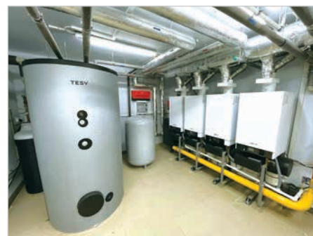
Nowa kotłownia gazowa w SP-2.
