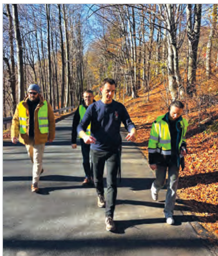
Odbiór wyremontowanego odcinka drogi na Równicę.
