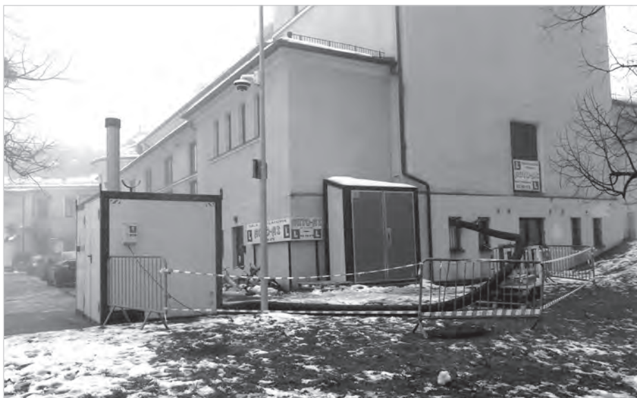
Za budynkiem „Prażakowki” stanęła tymczasowa kotłownia.
