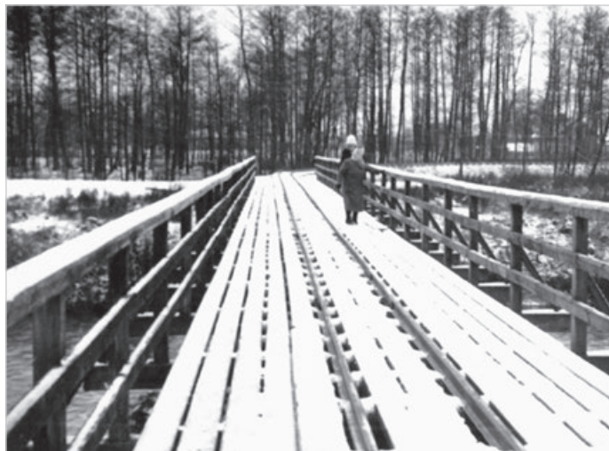
Alojzja i Anna Bukowczan na moście kolejowym cegielni. Widoczna jest ówczesna drewniana konstrukcja mostu oraz szyny kolei wąskotorowej. W tle zabudowania rodziny Szymalów. Ok. 1965 r.
