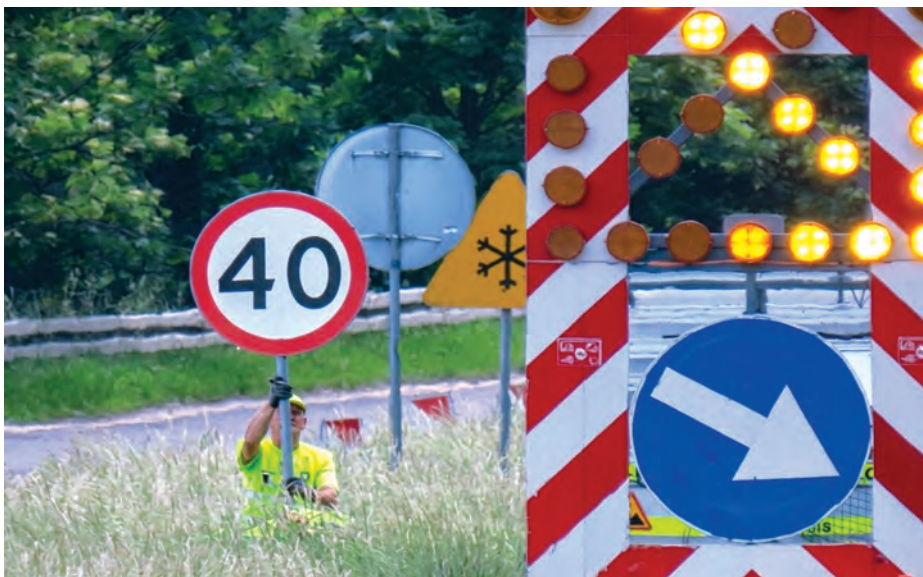
Na drodze wojewódzkiej trwają prace remontowe i pielęgnacyjne.
