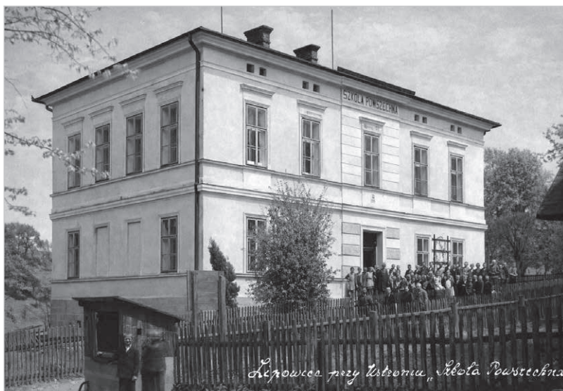
Budynek szkoły ludowej w Lipowcu, oddanej do użytku 12 lutego 1899 r. Na pierwszym planie studnia w drewnianej obudowie.
