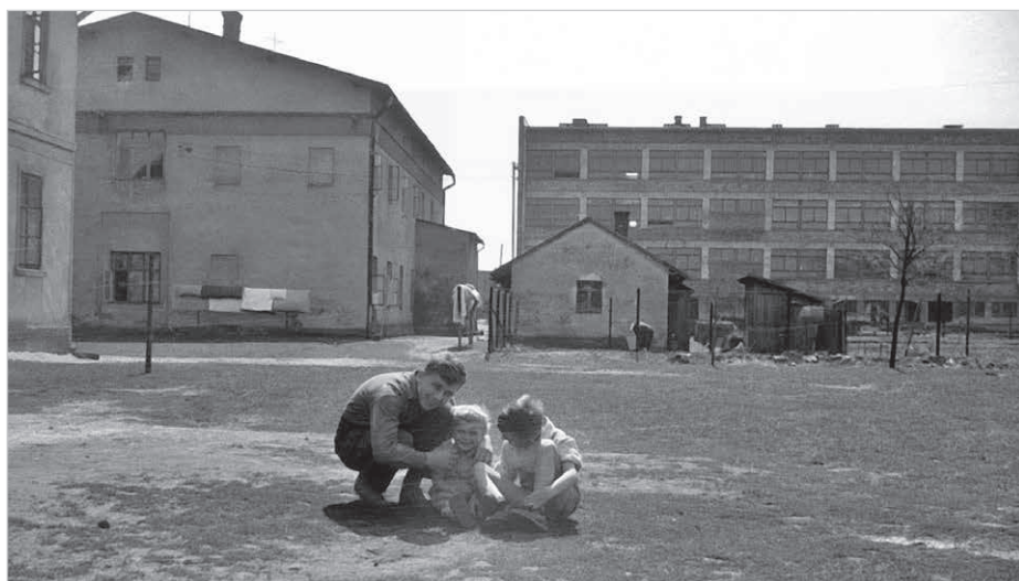
Widok z placu Wielkiego Domu na Stary Dom, przynależne szopy i ogród z grządkami. W tle budynek Szkoły Podstawowej nr 1, tzw. tysiąclatki, w końcowym stadium budowy, 1962 r. Fot. Józef Górka
