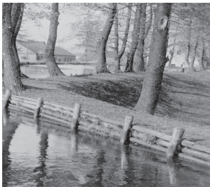
Staw przy Młotowni „Alberta”, czyli staw fabryczny (Werksteich), 1816 r. Na pierwszym planie widoczne umocnienia brzegów, w tle od lewej: tokarnia arcyksiążęca, domek strażników turbiny oraz budynek kuźnicy. Idylliczny krajobraz tej części Ustronia przeszedł już do historii, a fotografię udostępniła przed laty Wanda Kosowska.
