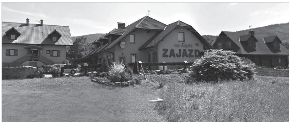
Zajazd na Kępie przy u. Katowickiej II wybudowany przez Eugeniusza Langhamera.
